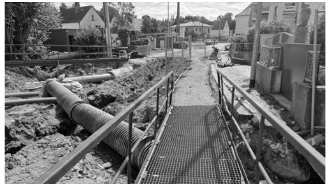
Zottewitz, Bachumleitung Ritzschge mit Behelfsbrücke für Fußgänger
