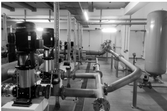
In der DEA Großenhain-West investierte die WRG in neue Pumpen.
